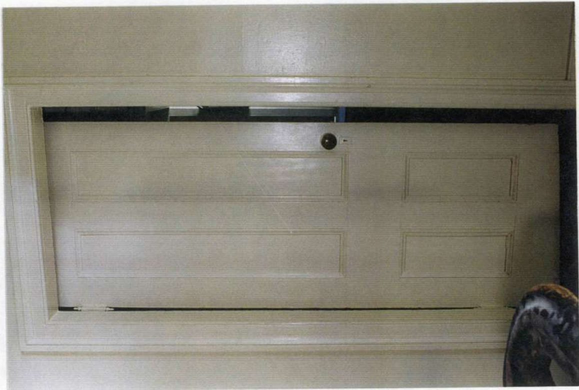
195a. Door to closet 210B.
